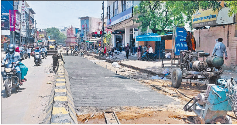
रेवाड़ी। सरकुलर रोड पर चल रहा सड़क निर्माण कार्य।
